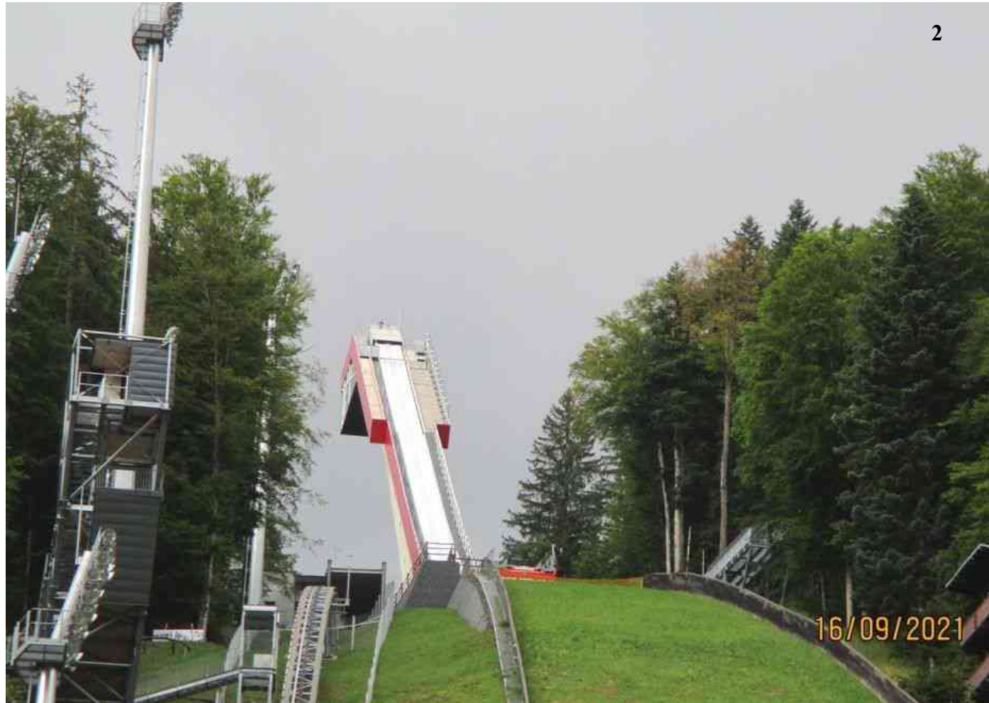
Blick von SO auf Sprungturm. Buchen und Fichten zeigen Kronenschäden.
