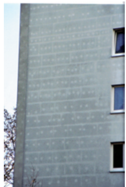
Südwest-Fassade mit Wärmedämmverbundsystem (WDVS)
