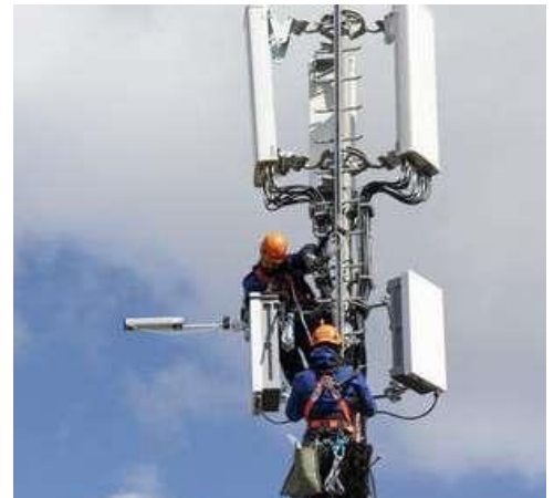
Foto: Installation von 5G-Sendern
